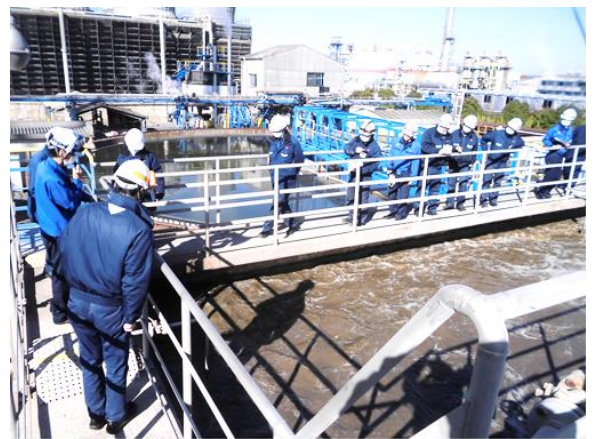
〈共同排水処理利用会社への研修（施設見学）〉
