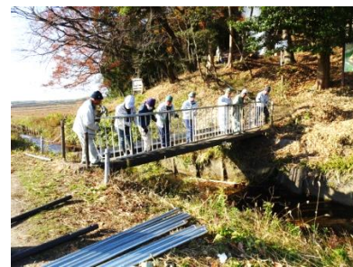
〈A地区入口橋手摺り取付〉
