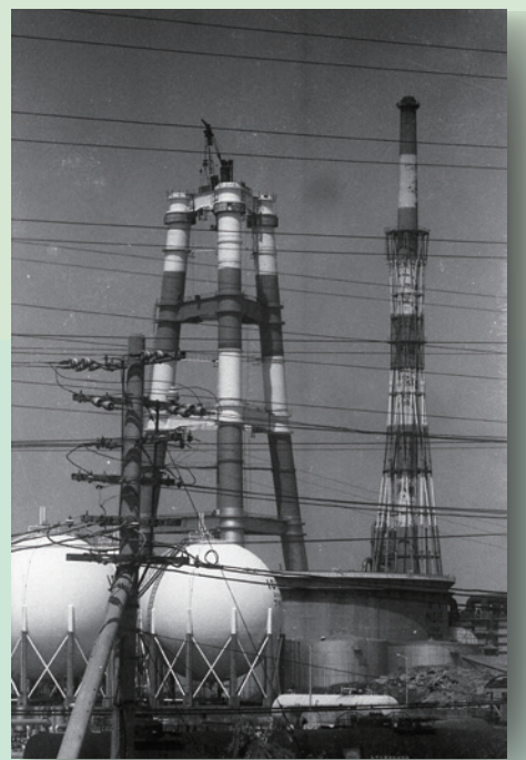
Xây dựng ống khói cao
