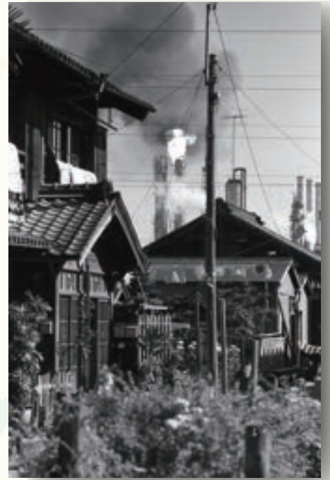
煙突のフレアスタック
