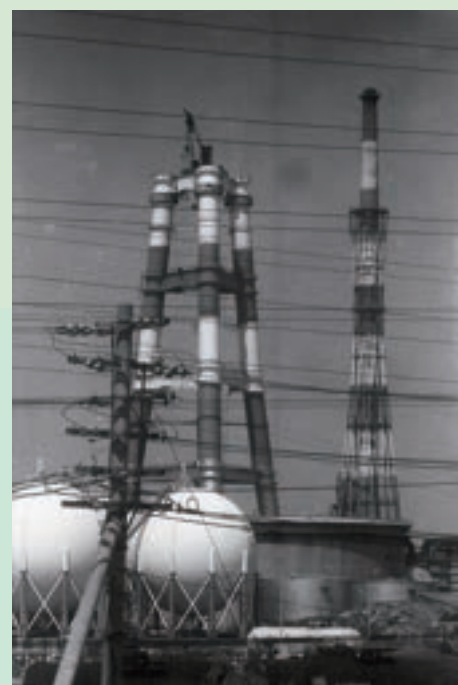
高煙突の建設
