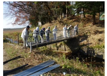
〈A地区入口橋手摺り取付〉
