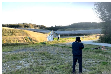
《桜地区 民家の前はパネル設置を回避》
