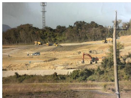
《2019年11月足見川メガソーラー造成工事、西エリア地区の現場》
