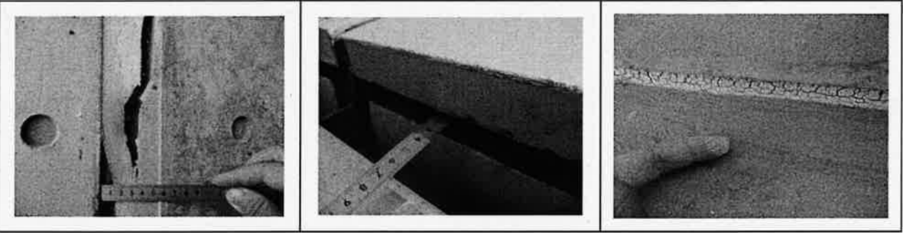
写真 シーリング材使用状況
