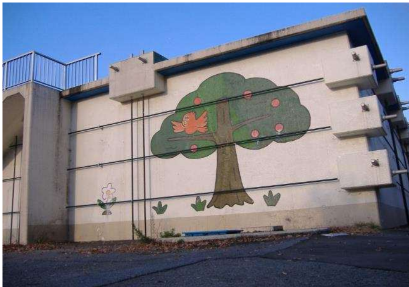
一生吹配水池
