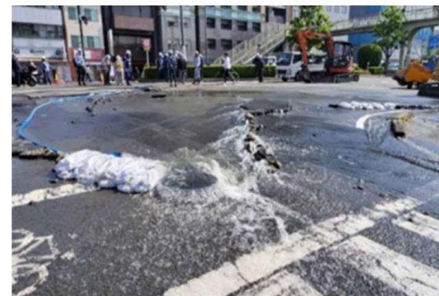
漏水状況(R7.4京都市)※
