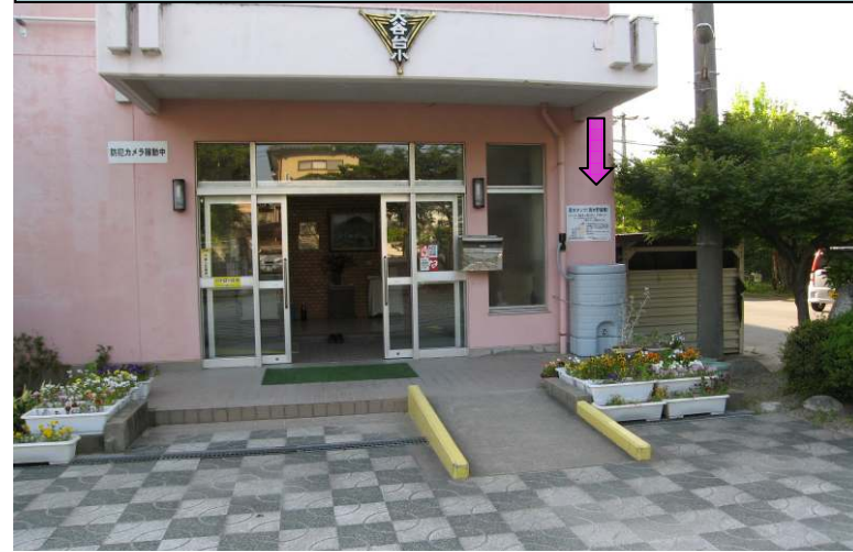
大谷台小学校にて【雨水貯留タンク】
