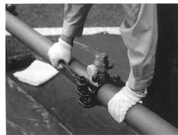
サドル付分水栓の取付け
