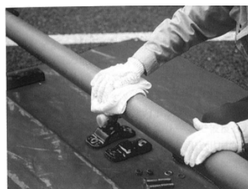
配水管の清掃
