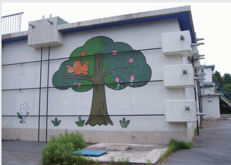
耐震補強工事(一生吹配水池)
