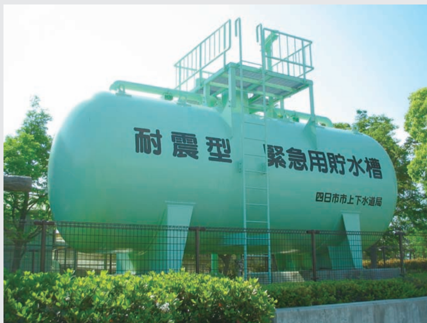
耐震型緊急用貯水槽（楠緑地公園内）
