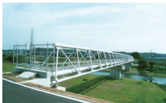
内部川水管橋
