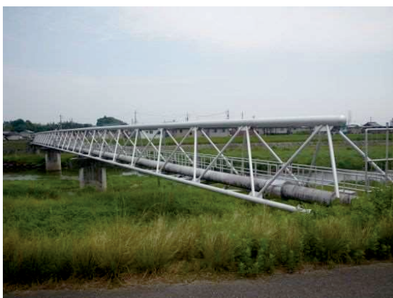
水管橋（内部川）
