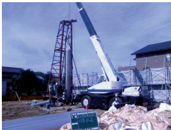
朝明 2 号井の更新工事の状況
