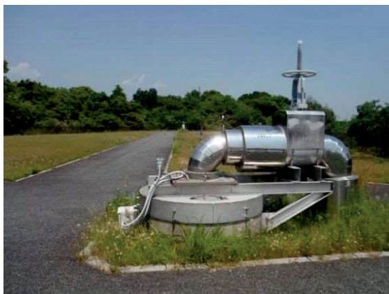
平尾取水場の取水井（井戸）
