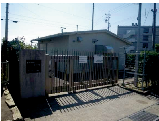
羽津山加圧ポンプ所のポンプ室
