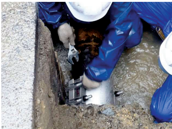
管路の漏水修繕の状況
