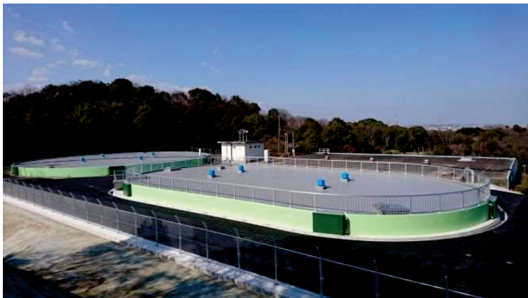
山ノ手配水池
