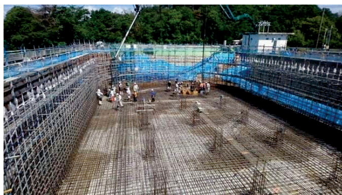
山ノ手配水池（1号池）の更新工事の状況
