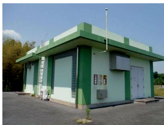
平尾取水場の発電気室
