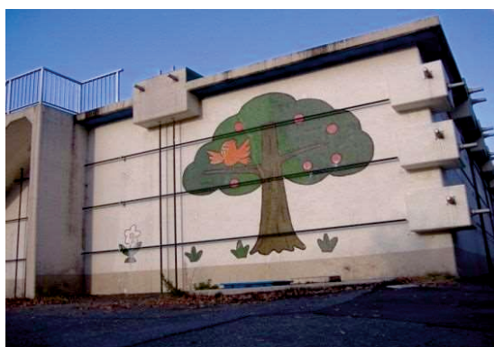
一生吹配水池の耐震化の状況
