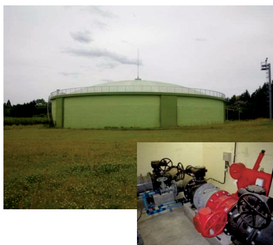
水沢北谷配水池（緊急遮断弁）
