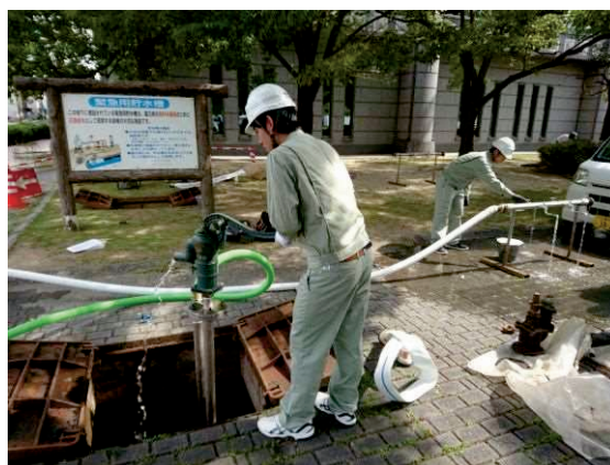
職員による応急給水訓練（緊急用貯水槽）
