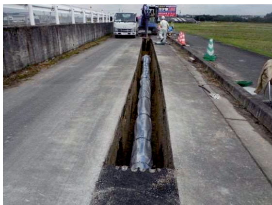
管路（耐震管（ダクタイトル鉄管 NS 形）口径 300 mm （ポリエチレンスリーブ被覆））の埋設状況
