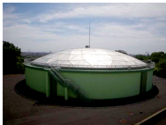
生桑配水池（2号池）
