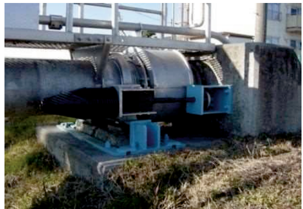
水管橋の上部工の落橋防止対策の状況
