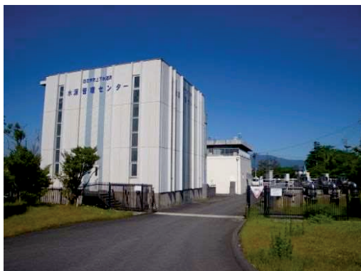
水源管理センター（三滝水源地内）
