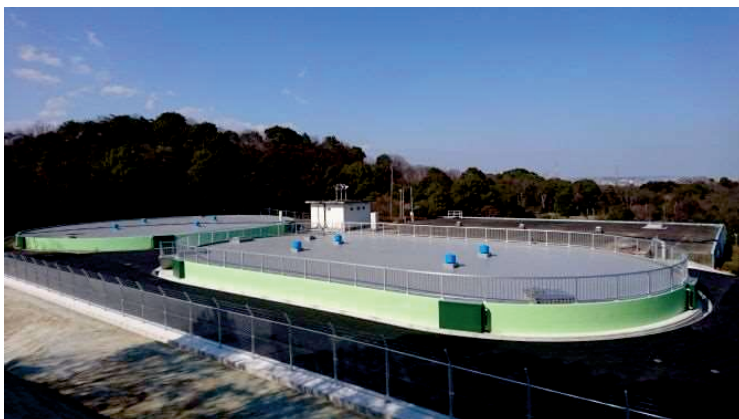
山ノ手配水池
