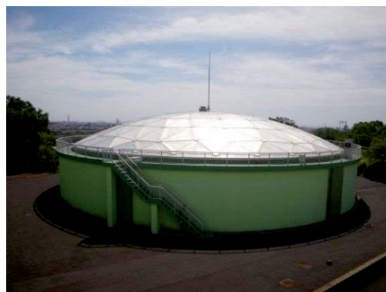
生桑配水池（2号池）
