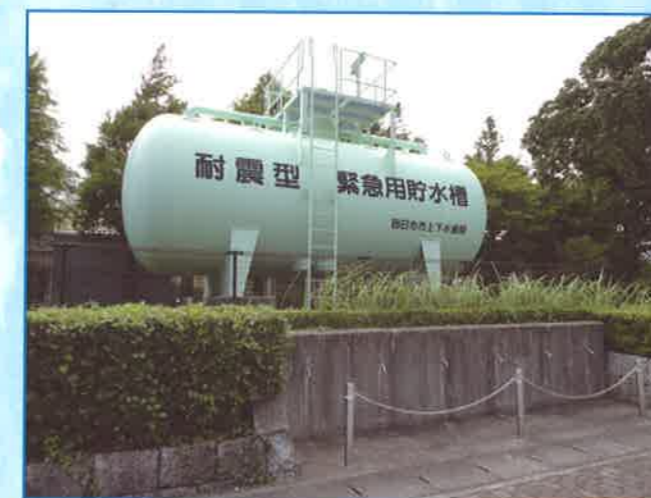
【Tanque de água em caso de emergência (Térreo)】 Este é o tanque térreo de água em caso de emergência.
