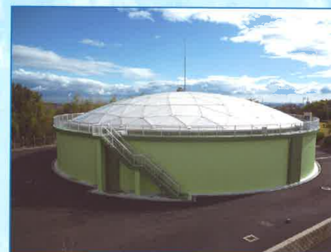
【Reservatório (Com válvula de fechamento de emergência)】 Instalação que fornece água potável em caso de desastres.
