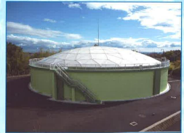
【Estanque de distribución de agua (con válvula de cierre de emergencia)】
