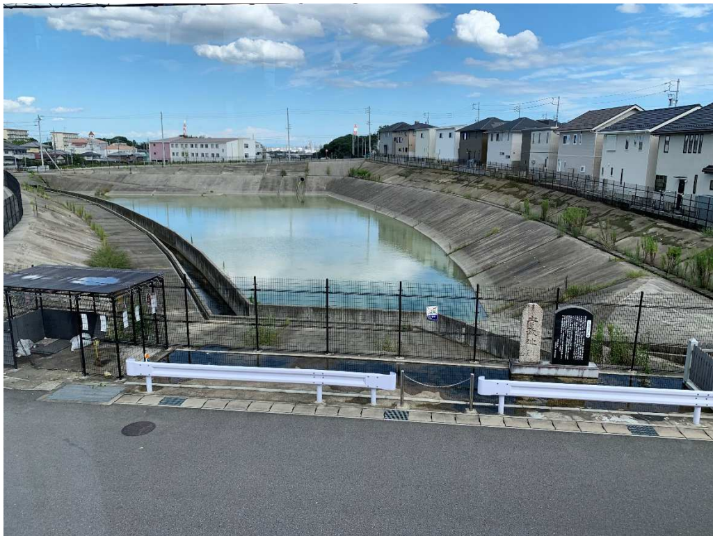
写真1：調整池の施工例
