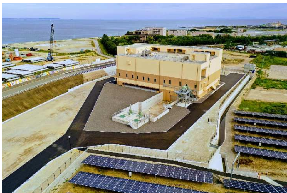
写真 3 : 吉崎ポンプ場
