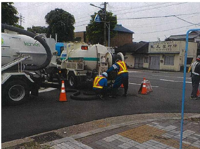
緊急点検のほかに、平時から汚水管内を清掃したうえで、自走式テレビカメラを挿入して計画的に調査を実施しています。
