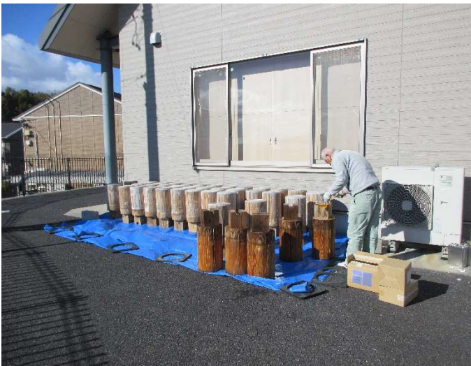
遺構表示木柱への防腐剤塗布
