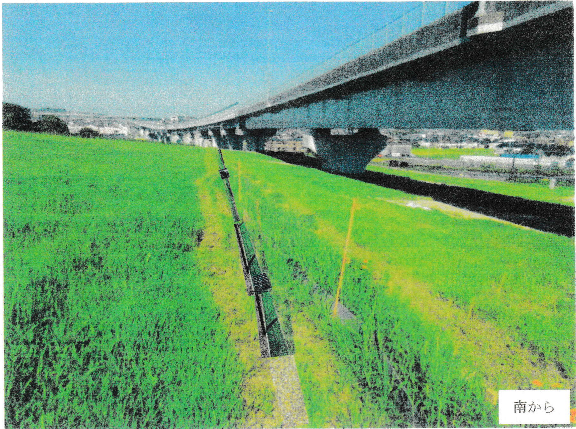
排水路（景観グレイチング・皿形側溝）
