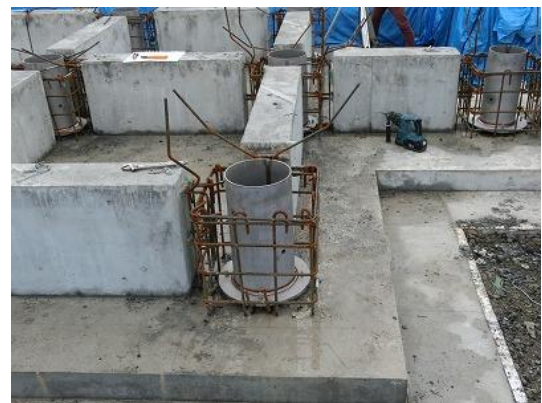
9月25日 柱脚金物設置
