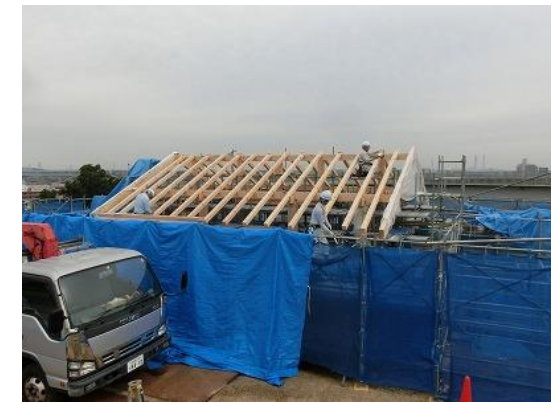
10月16日 垂木施工
