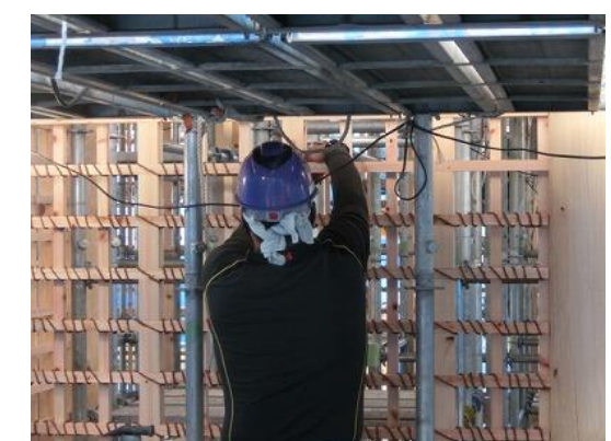
11月5日 木舞施工
