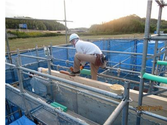
10月19日 塀壁板施工
