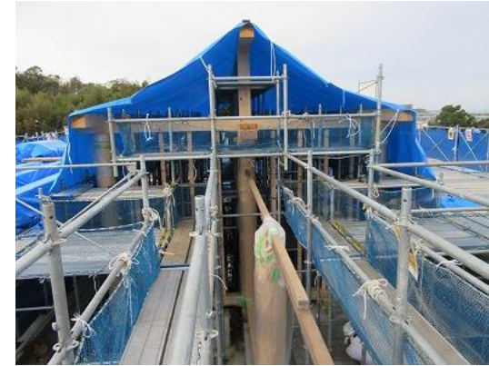
10月12日 棟木施工
