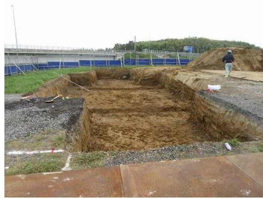
8月28日 基礎掘削
