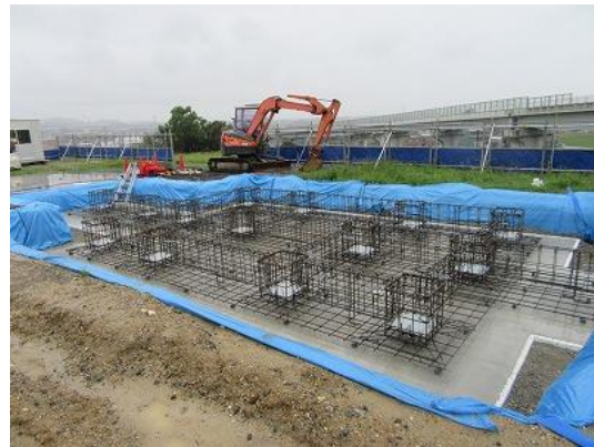
9月10日 基礎配筋
