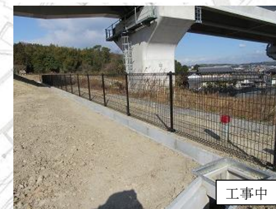
雨水排水溝設置
