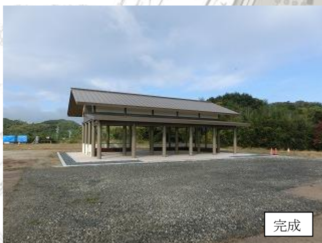
正殿建設工事
