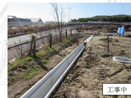
雨水排水溝設置
