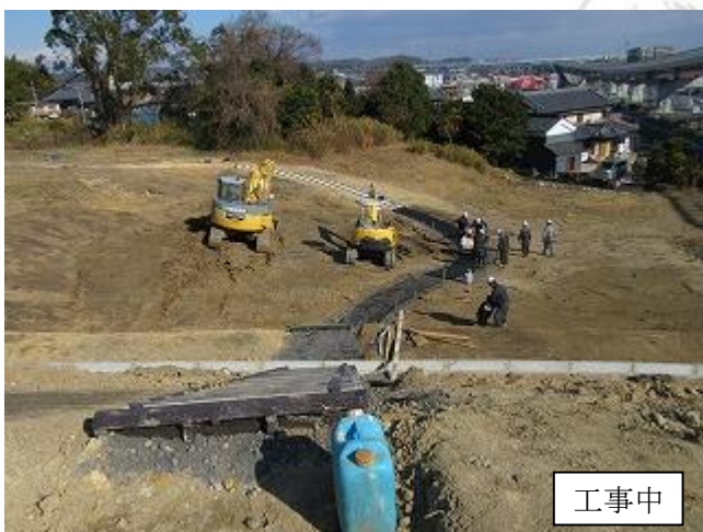
北地区散策路整備
