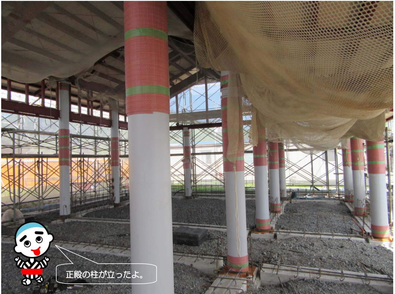
正殿建設の工事風景
