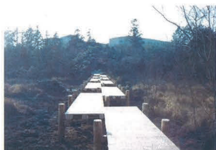
昭和 55 年観察橋完成時の状況
