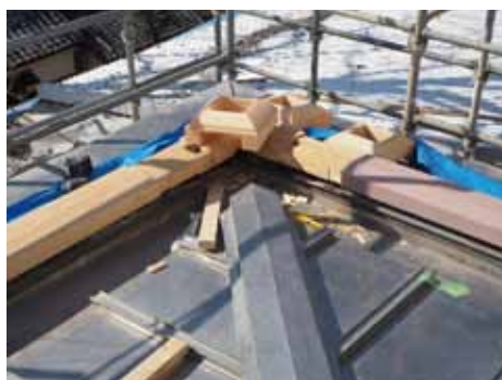
▲車寄せ手摺りの修理
