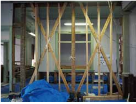
▲旧事務室西壁内の筋違
