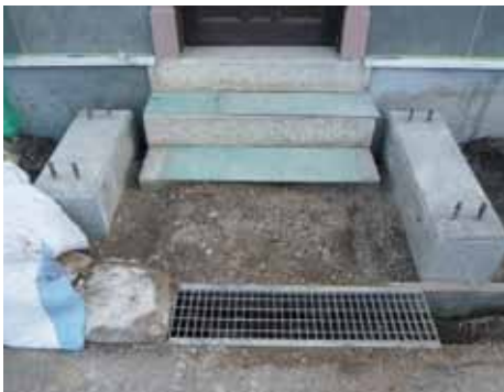
▲外スロープの基礎
