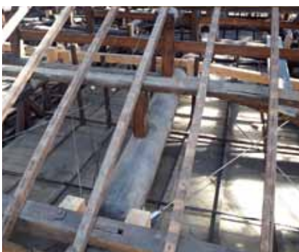
▲和組の新材補強と水平プレス
