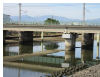
J R関西本線の三滝川橋脚
