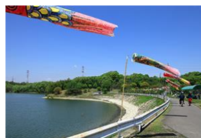
伊坂ダム（四日市市文化まちづくり財団 HP より）
