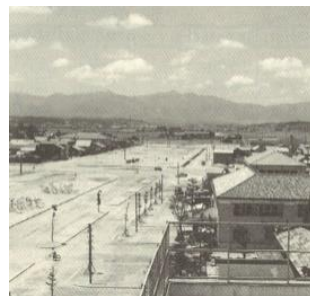
戦災復興事業により完成した 70m 道路 (1952 年頃) (「四日市市史」)
