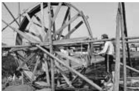
掘り抜き井戸を掘る方法(中野町)
