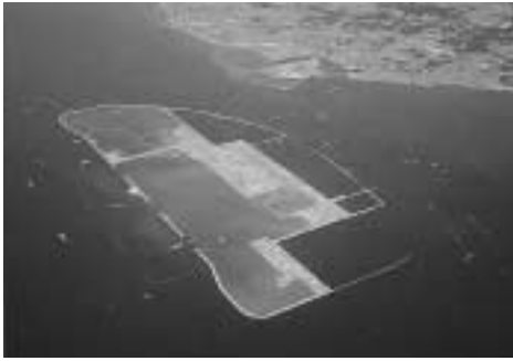
9月12日現在の建設工事状況 (中部国際空港株式会社H.P.から)
