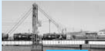
末広橋梁 JR四日市港線の橋で、中央部をワイヤーで引き上げて船舶を通します。稼働する跳ね上げ橋としては日本最古で、平成10年に国の重要文化財に指定されました。臨港橋から徒歩2分
