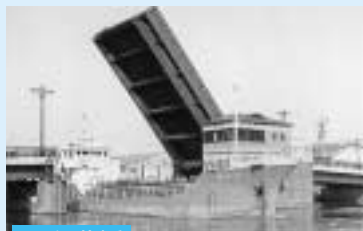
臨港橋 千歳運河に架かる橋で、中央部を油圧ジャッキで押し上げて船舶を通します。四日市港行き「四日市港口」下車徒歩1分
