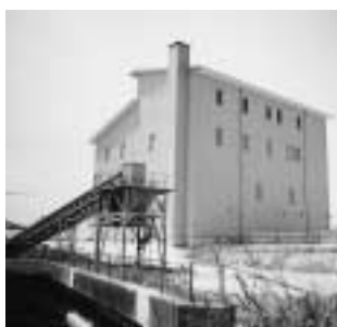
朝明ポンプ場（増設部分）
