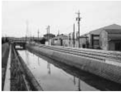
引き続き整備が進む米洗川
