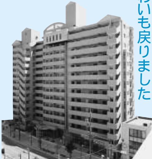
地域8軒の協力で建てられた共同住宅
