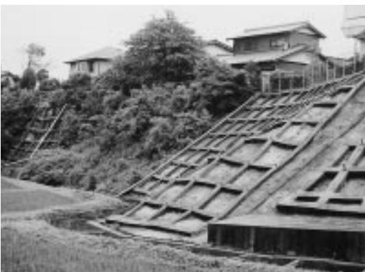
斜面が強化された急傾斜地危険個所
