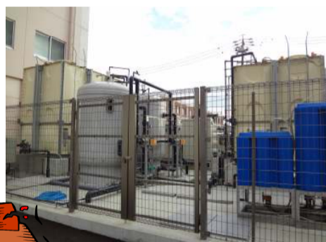
地下水供給装置
