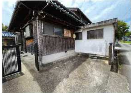
(入口:駐車スペース)
