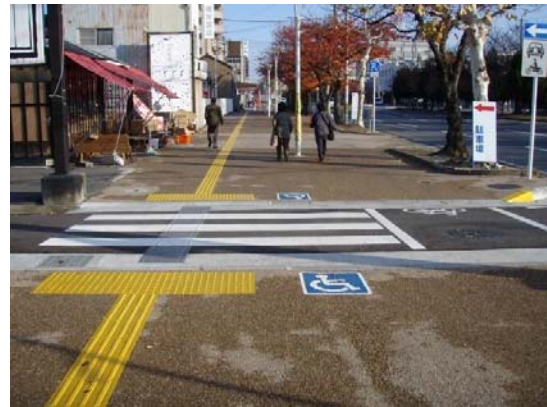
段差のない歩道
