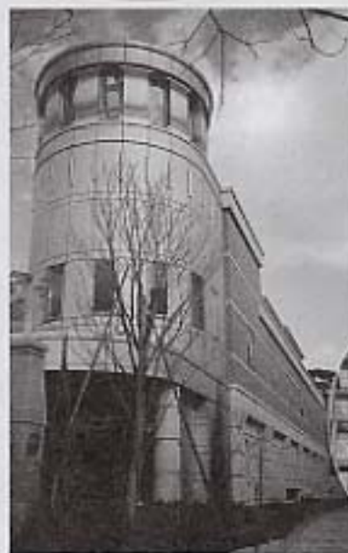
西側外観部・全館
