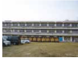
小学校(避難所)トイレ(男女別なし)
